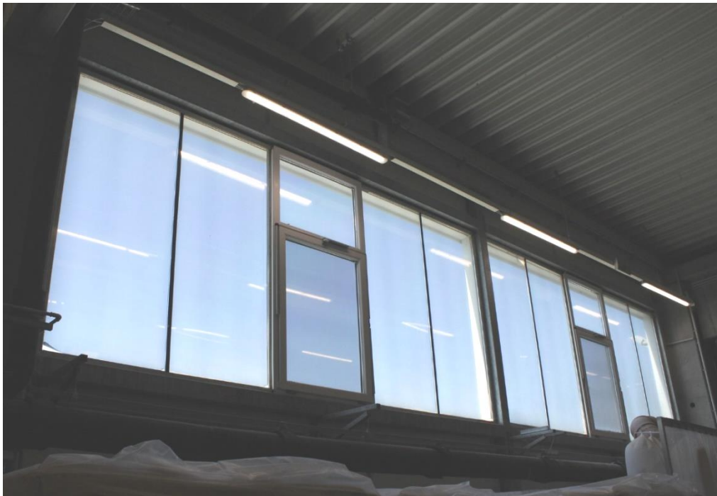
Abbildung 3: Sonnenschutzfolien an der Südwestseite der Produktionshalle
