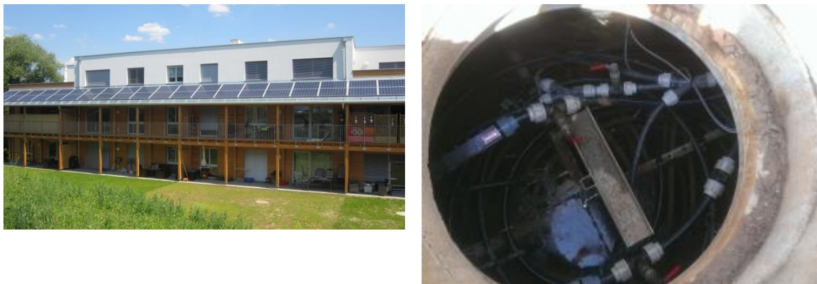
Abbildung 42: Links: Foto des mit Eisspeicher geheizt und gekühlten Wohngebäudes, rechts: Foto des noch leeren Eisspeichers 52
