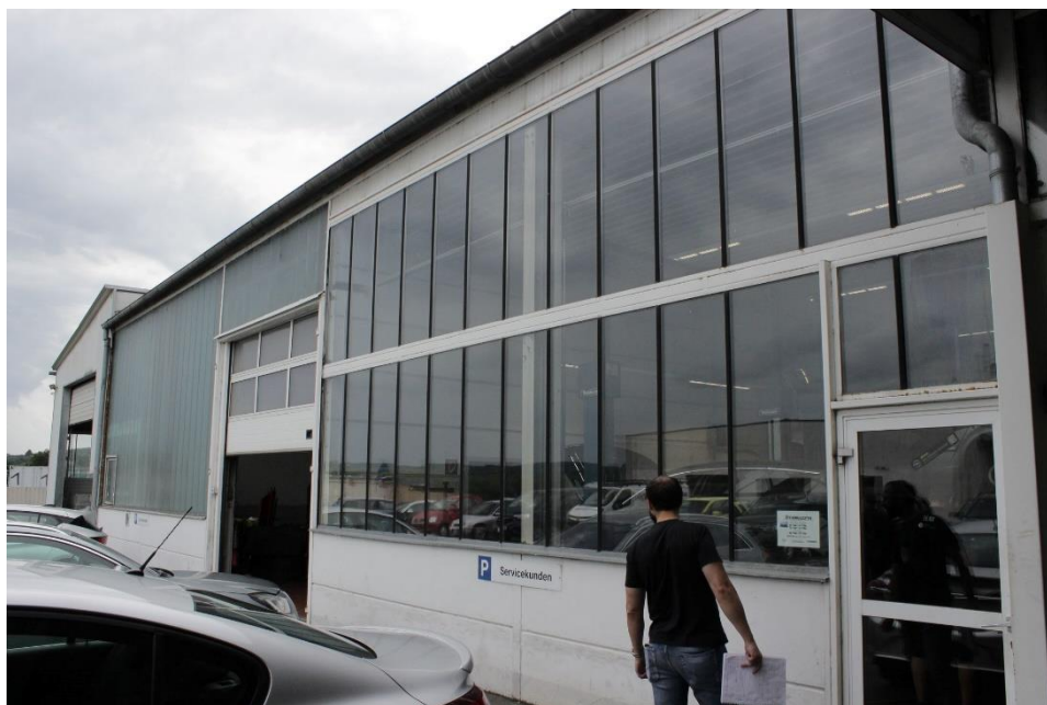
Abbildung 7: Der Wärmeintrag durch die südseitige Glasfassade der Werkstatt ist besonders hoch
