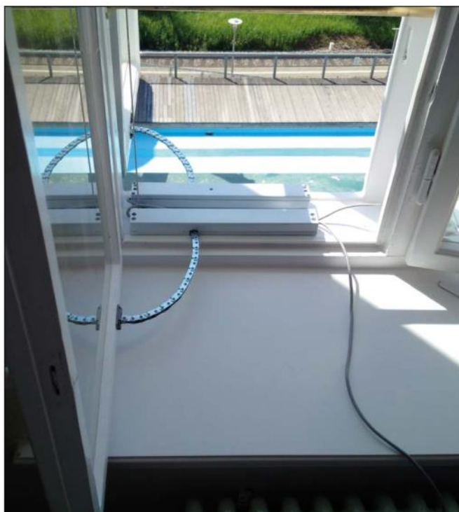
Abbildung 26: Stellmotor des Kastenfensters 23
