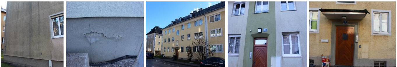
Abbildung 17: Fassade, Sockelbereich, Dach, Fenster und Eingangsbereich
