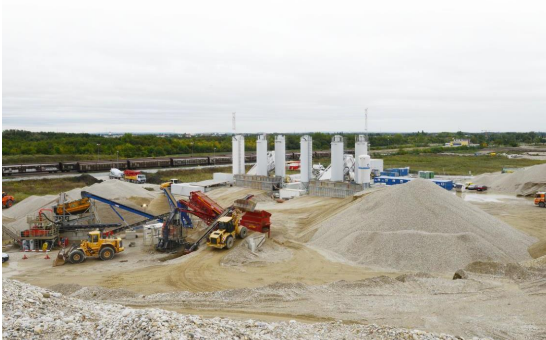
Abbildung 33: Ortbeton Anlage in der Seestadt Aspern. (C) Karoline Mayer
