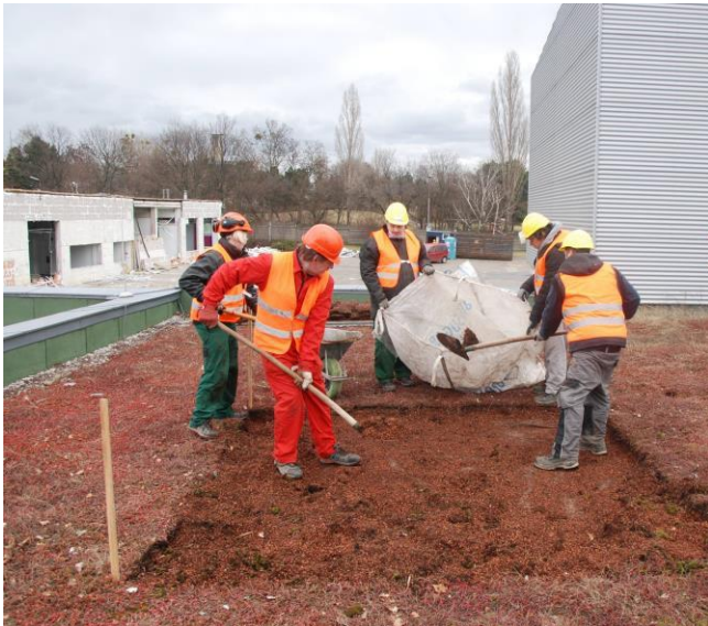
Abbildung 34: MitarbeiterInnen des BauKarussells bei der Abtragung der Dachbegrünung. (C) BauKarussell
