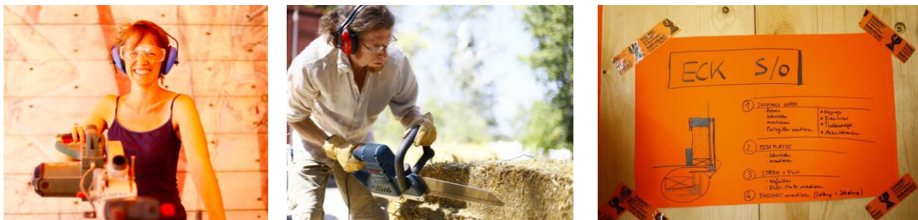
Abbildung 23: Baustellenorganisation und -sicherheit, Fotos: Florian Hörantner
