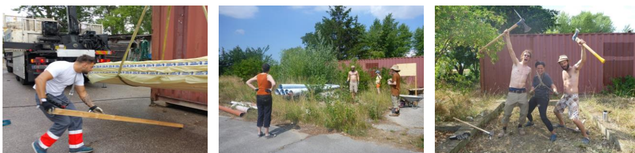
Abbildung 21: Baustelleneinrichtung, Fotos: David Marek
