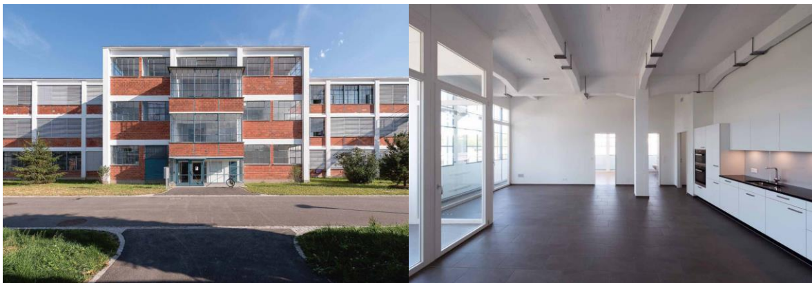
Abbildung 6 (links) Abbildung 7 (rechts): ehemalige Produktionshalle mit Haus-im-Haus Konzept 24
